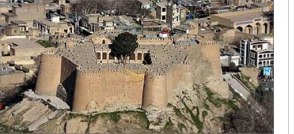
زلزله اخیر در لرستان نگرانی کارشناسان از آسیب قلعه فلک‌الافلاک را به همراه داشته است
