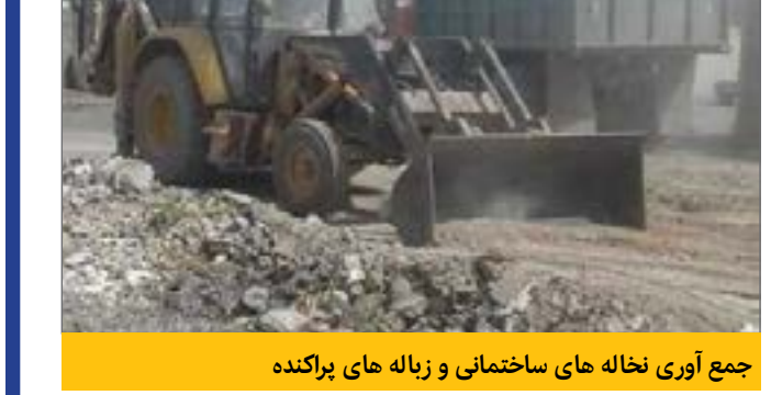
جمع آوری نخاله های ساختمانی و زباله های پراکنده
