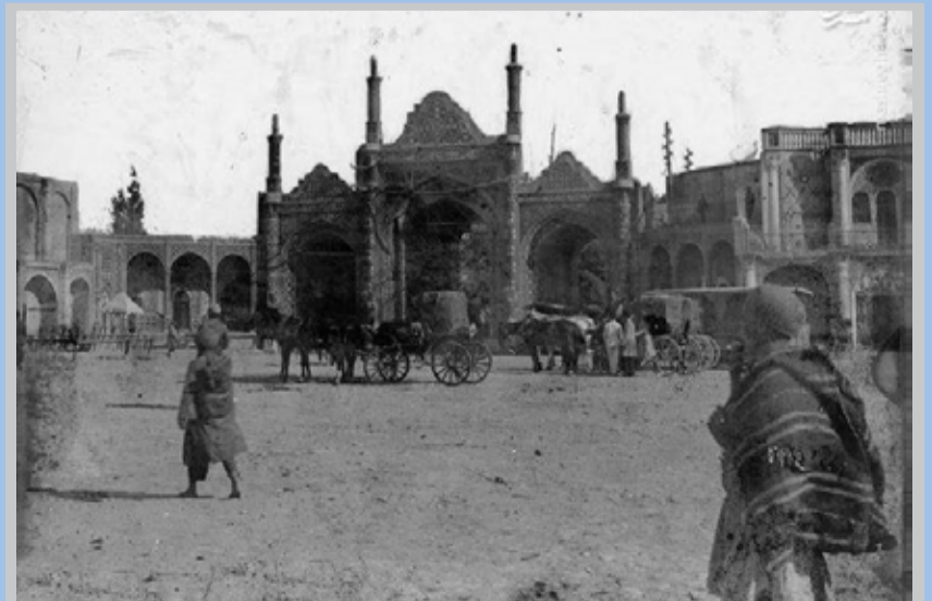
شکل و شمایل دروازه دولت در دوره قاجار / مشرق
