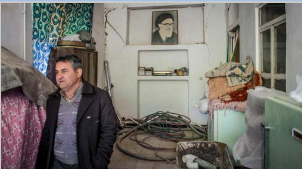
برخی از ساختمانها اگرچه از بیرون سالم به نظر می آیند اما از داخل ترک خورده اند
