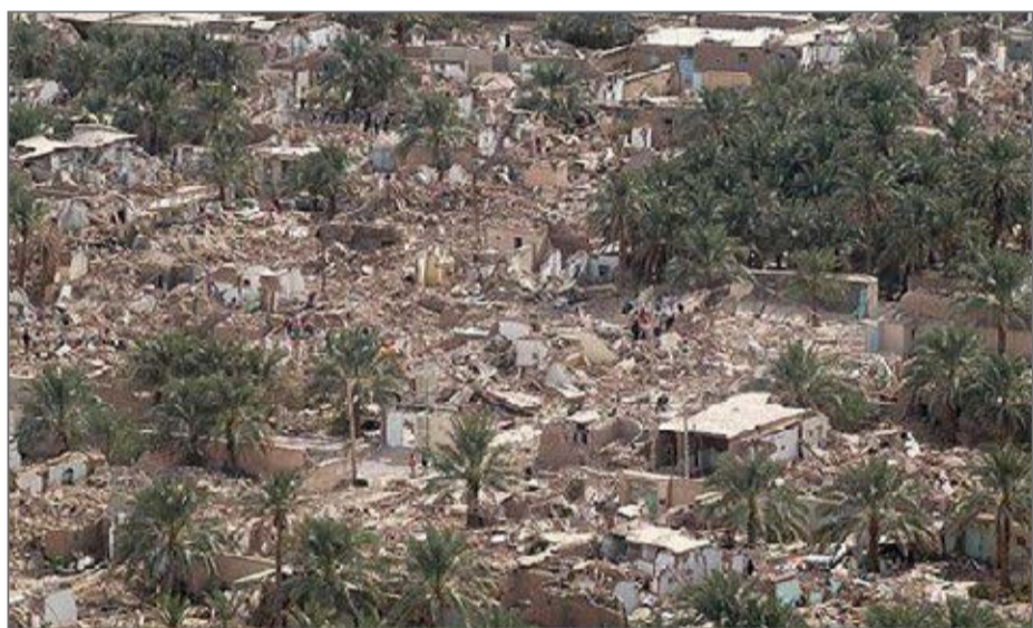
زلزله بم در سال ۸۲ موجب تخریب بیش از ۶۰ درصد این شهر شد
