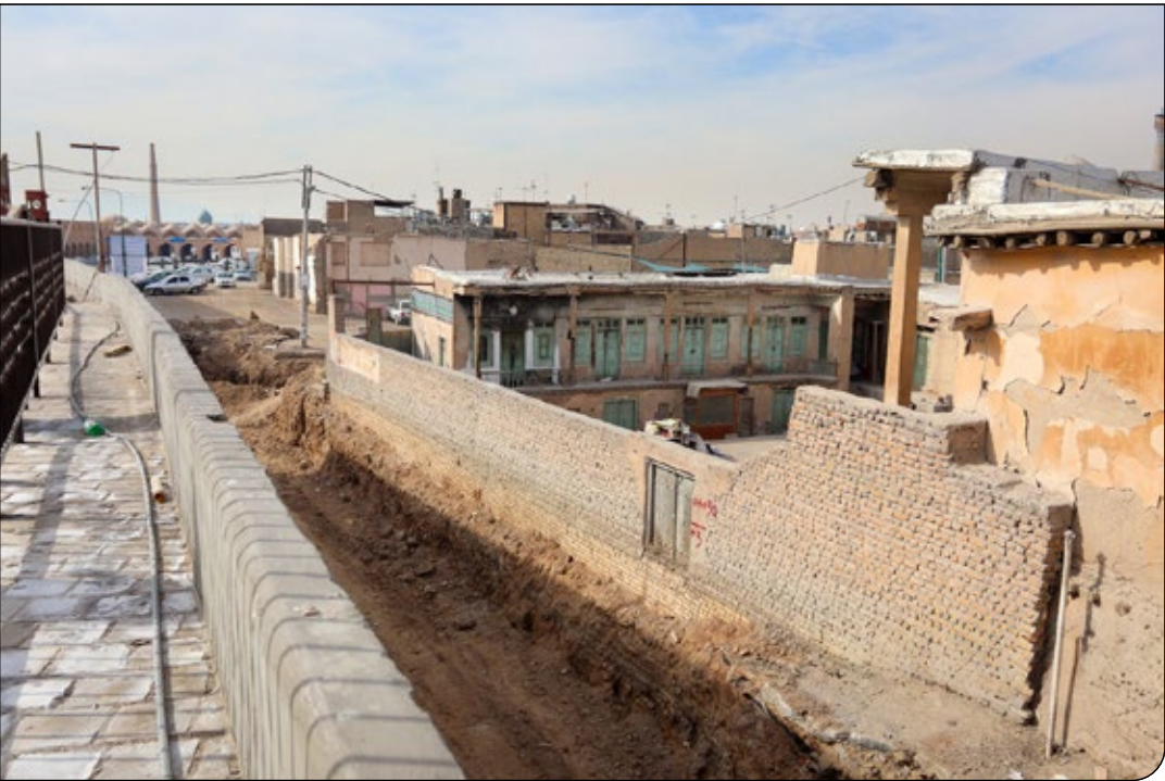
ایستگاه راه‌آهن اصفهان در حال احداث، بهار ۱۳۵۳
