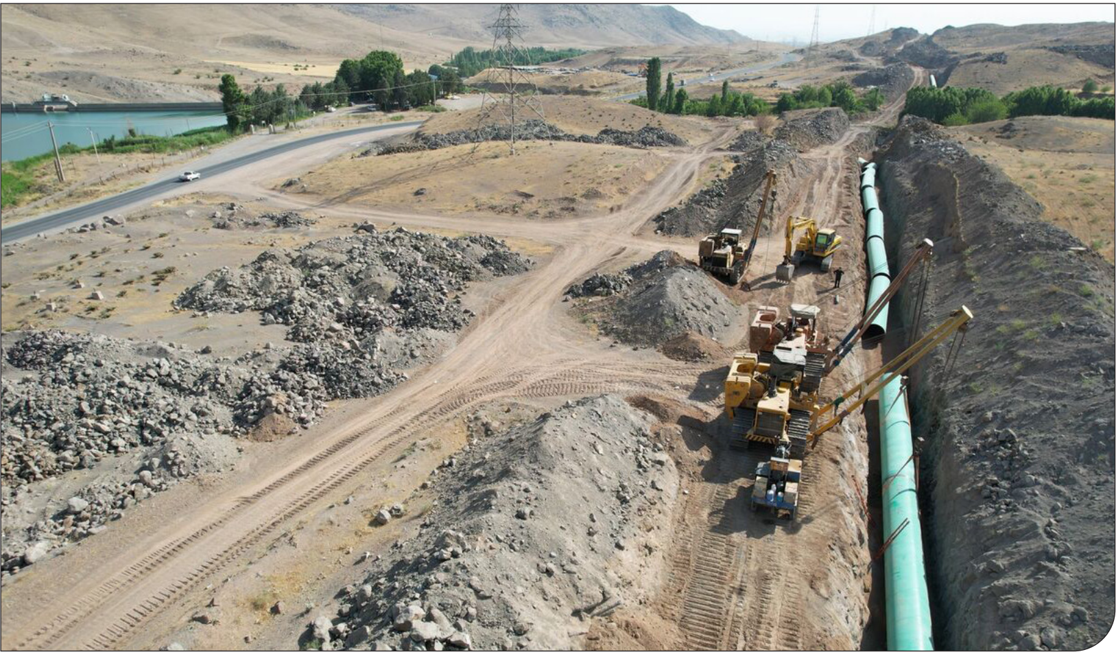
پروژه انتقال آب طالقان
