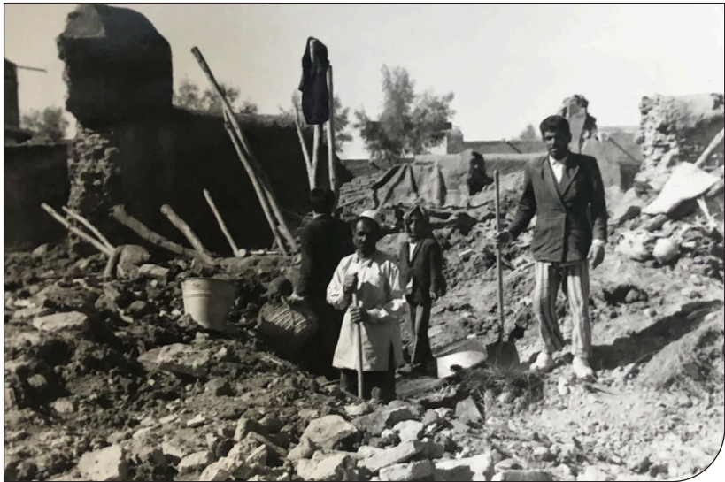
خرابیه‌های زلزله سال ۱۳۶۳
