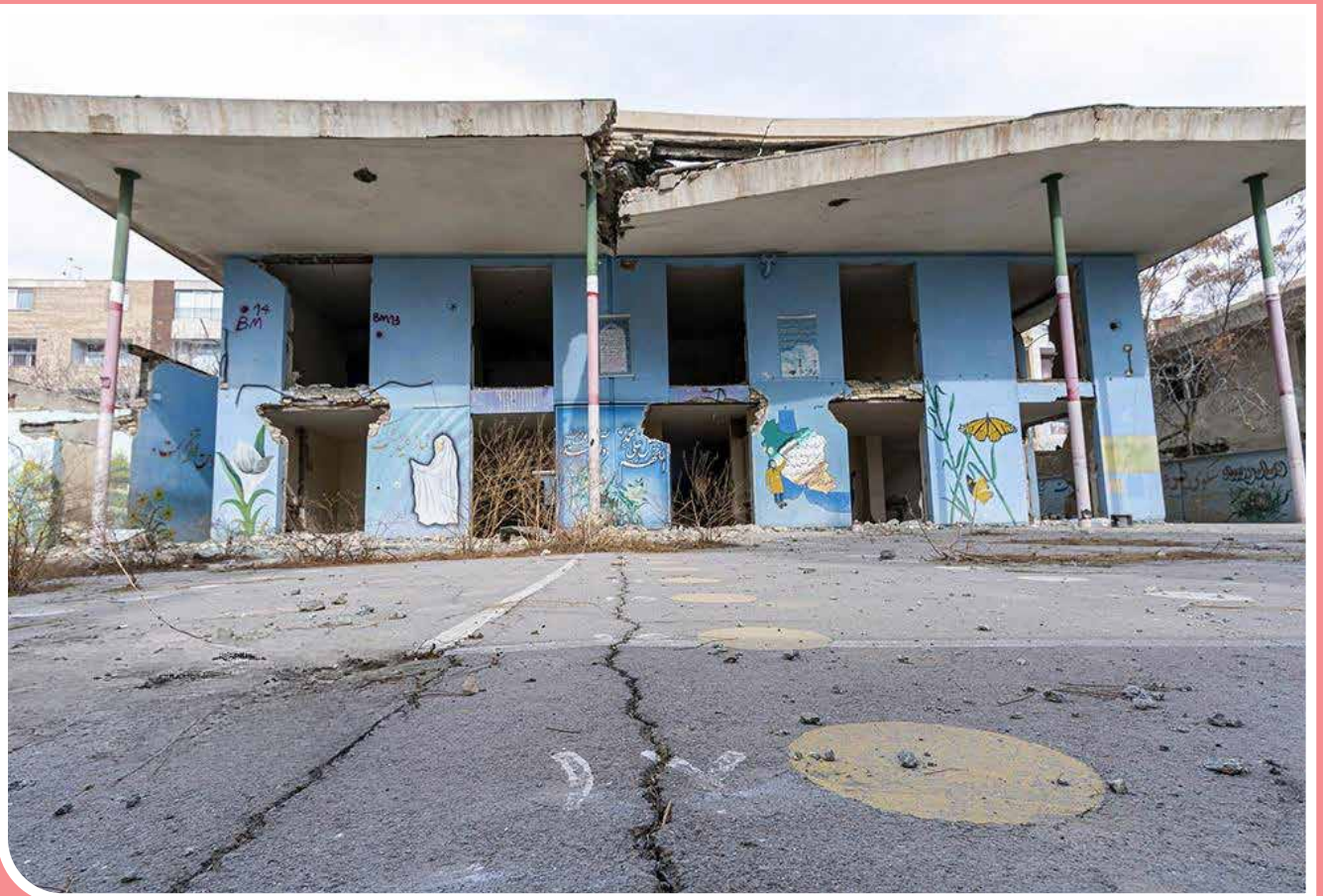
طبق آخرین آمار تا پایان آبان‌ماه ۱۴۰۳ حدود ۱۵۰ مدرسه استان اصفهان تحت‌تأثیر فرونشست قرار گرفته‌اند که از این تعداد، تاکنون ۴۲ مدرسه به‌طور کامل تخلیه شده‌اند. این تصویری از فرونشست یکی از این مدارس است که به همین علت، مدتی پیش ساختمان این آموزشگاه برای همیشه تعطیل شد.
