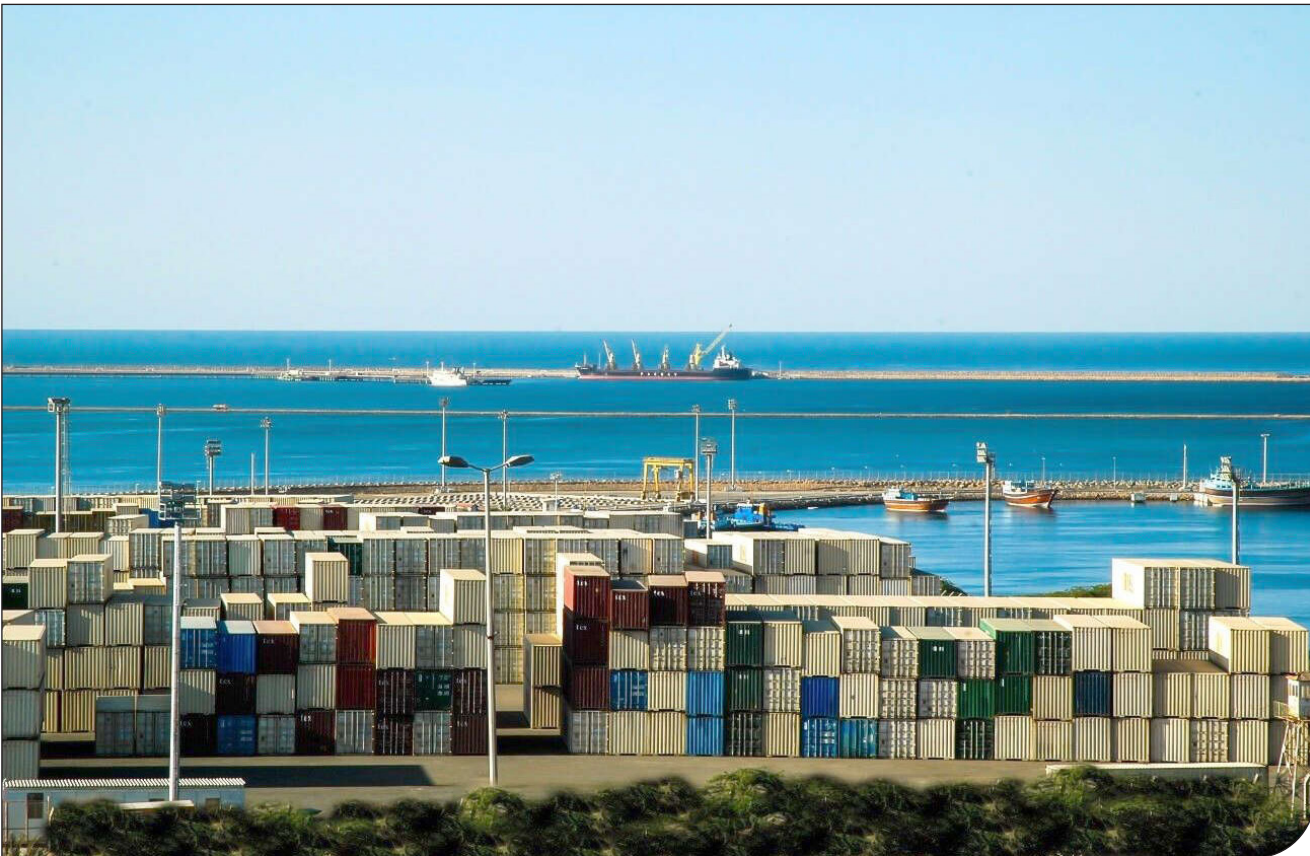
یک نمای هوایی از بندر شهید رجایی تهران در حال ساخت
