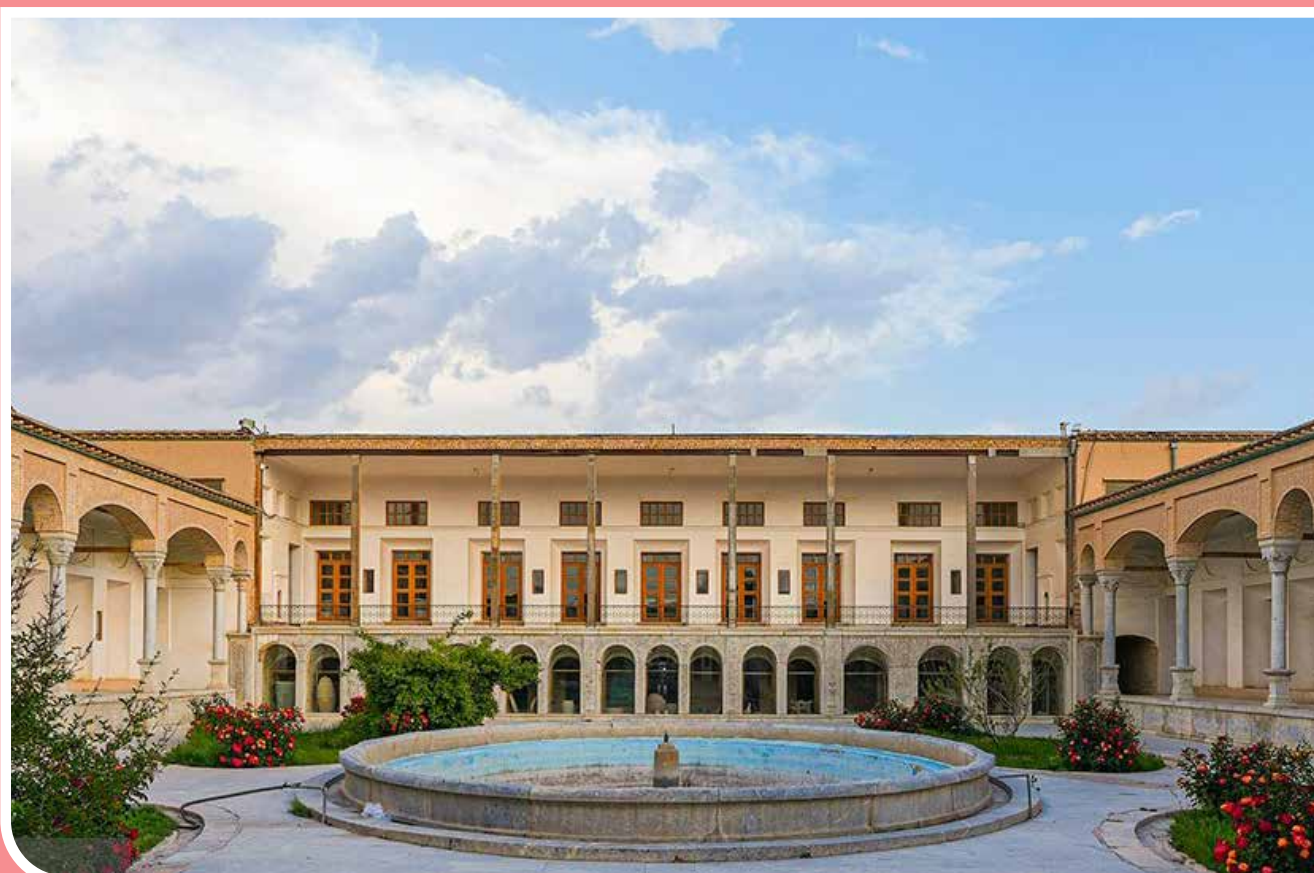
قلعه تاریخی «چالستر» در منطقه‌ای به همین نام و در پنج کیلومتری شهرستان «شهرکرد» واقع شده است. این قلعه به همت «خدارحم خان» در دوره قاجار و در سال ۱۳۲۳ هجری قمری در محلی که در دوران صفویه محل حکمرانی حکمرانان چهارمحالی بوده، بنا شده است. ساختمان قلعه دارای تزیینات نقاشی تلفیقی ایرانی-غربی با موضوعات افسانه‌ای و اسطوره‌ای، زندگی روزمره، گل و گیاه، گل و مرغ و نقوش فرشته و شامل بخش‌های سردر، هشتی، اندرونی و بیرونی، حمام، اصطبل و انبار است.
