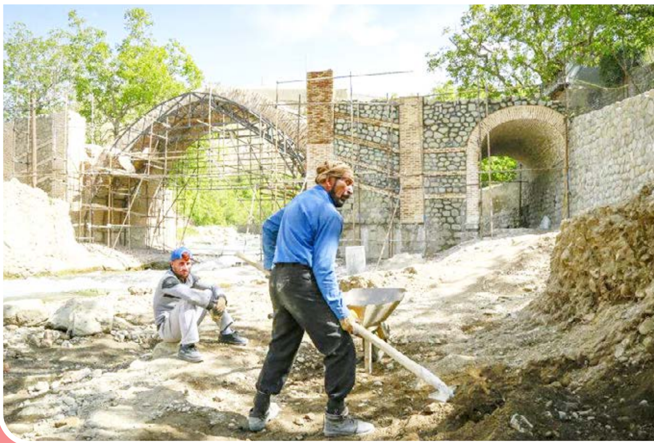
عملیات بازسازی پل خشتی کن / آژانس عکس تهران
