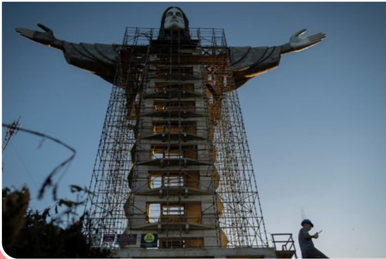
تندیس جدید در حال ساخت از مسیح (ع) در برزیل epa
